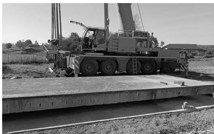
Stavba váhy na skládce inertního odpadu
