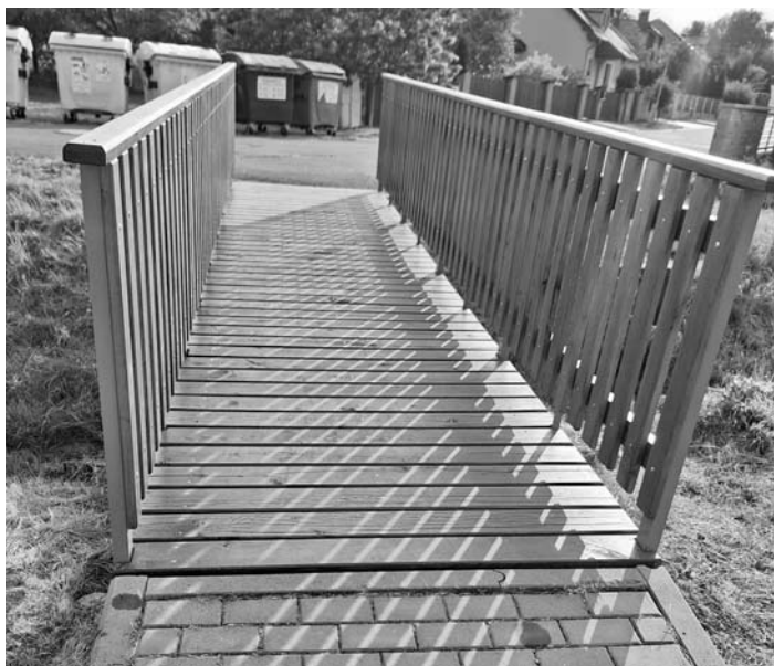
Opravená lávka u fotbalového hřiště
