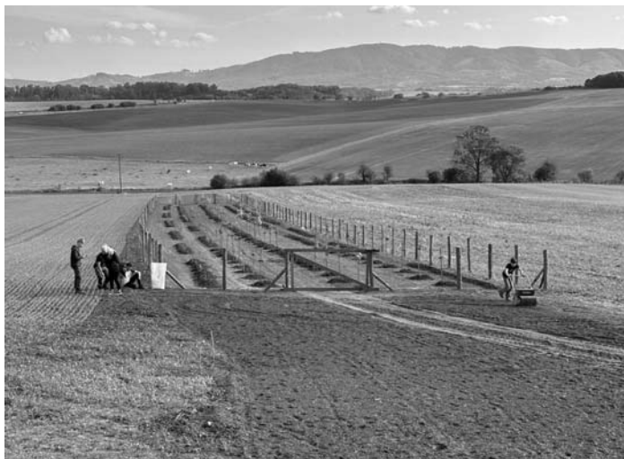
Budování biokoridoru na parc. č. 1575
